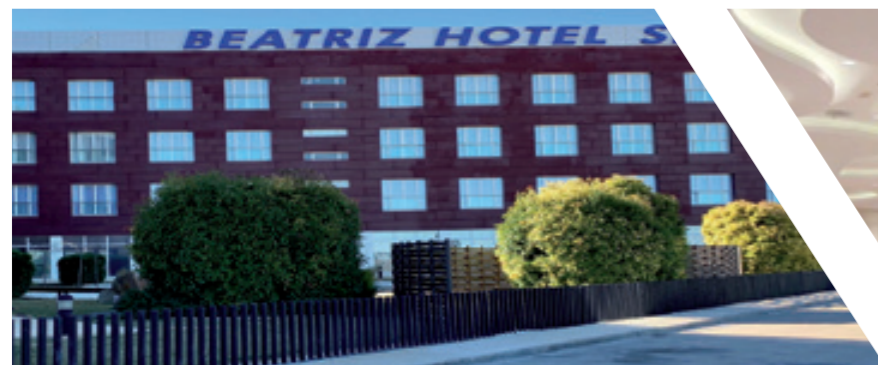
Hotel Beatriz & Spa, Albacete, Project Management e instalación electromecánica. cliente: Beatriz Hoteles-presupuesto: 35.150.000 €
