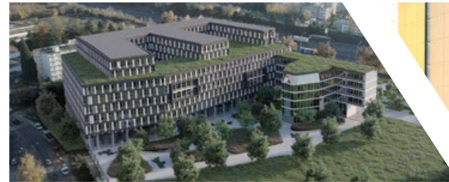
R.E. Campus Palaiseau, París (Francia), instalaciones electromecánicas. cliente: Floriot-presupuesto: 3.200.000 €
