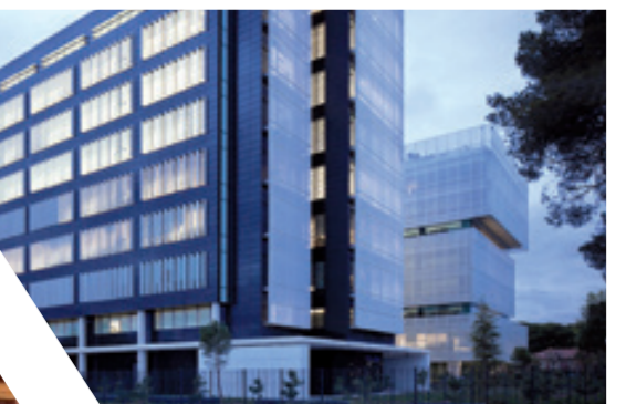
Edif. t-11 Iveco Pegaso, Madrid, instalación de climatización. cliente: Acciona-presupuesto: 2.000.000 €
