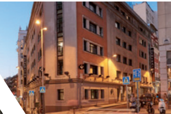
H. Generator, Madrid, instalaciones mecánicas. cliente: ACSA-presupuesto: 1.200.000 €
