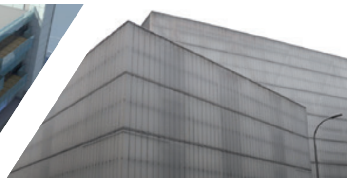
Mercado de Barceló, Madrid, inst. climatización. cliente: UTE Acciona-Dragados-presupuesto: 1.250.000 €
