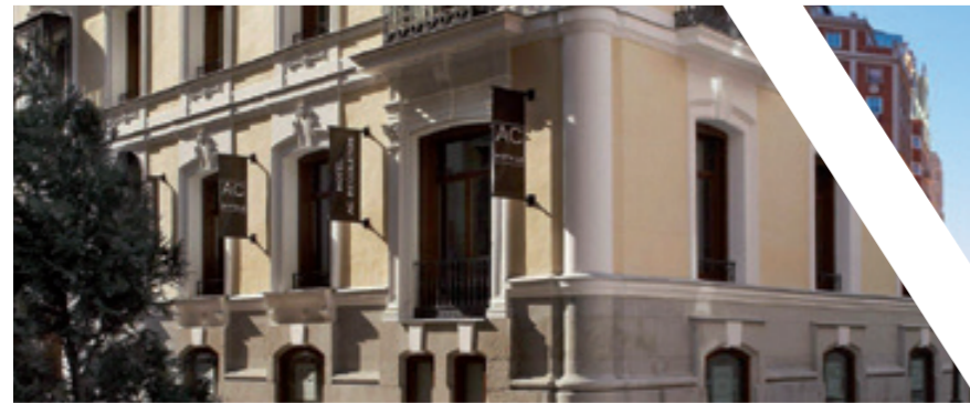
Hotel AC Recoletos, Madrid, instalaciones electromecánicas. cliente: Construcciones San Martín-presupuesto: 1.196.000 €
